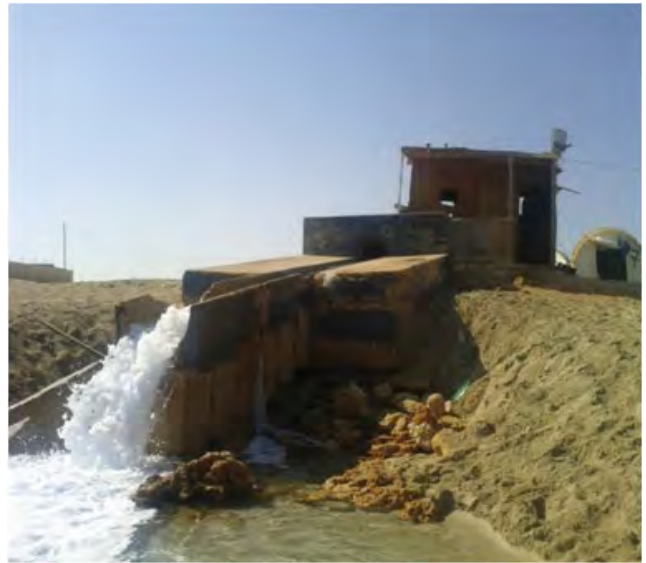
شكل ٤. نقطة تصريف الرجيع الملحي
