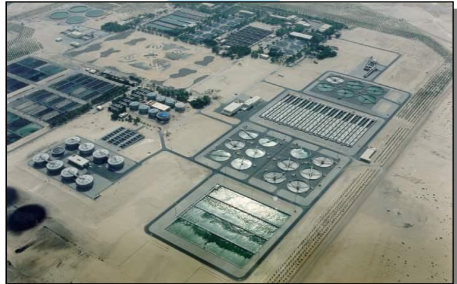
Abu Dhabi Mafraq WWTP activ.- sludge + denitrif.+ chlor. (300 000 m 3 /d.)
