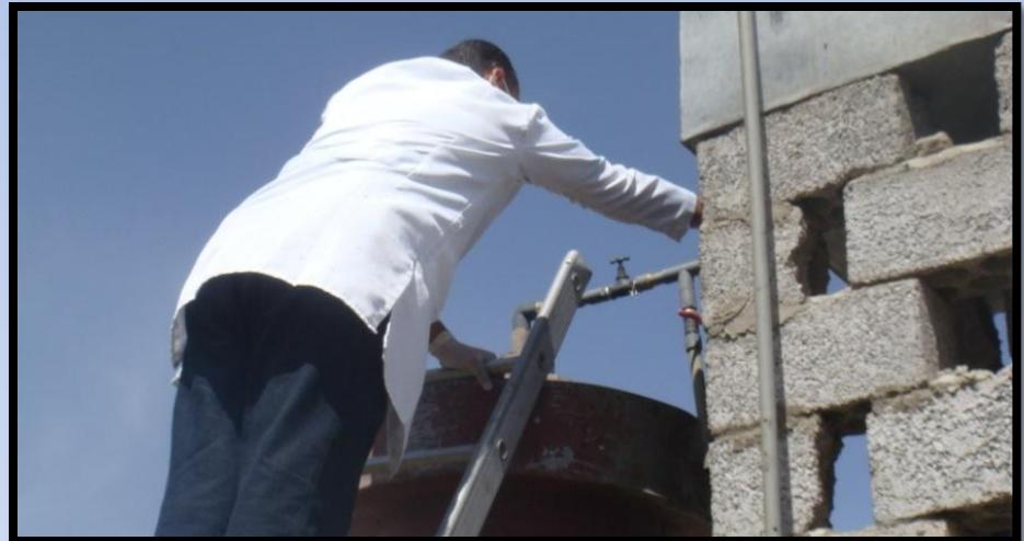
مرحلة الاستقرار :- تم تعبئة المفاعل بمياه نقية ثم بمية صرف مخففة بمياه نقية لمدة أسبوعين ثم بمياه الصرف الصحي ( فترة المكوث ٣٦ ساعة ) .
