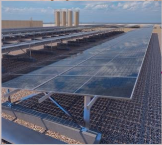
Solar PV Modules
